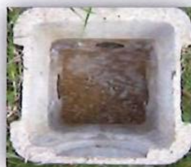
Photo regard de bouclage en béton, à trois arrivées, totalement sec.
